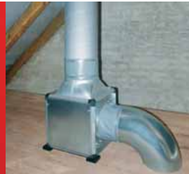
Монтаж в чердачном помещении на амортизаторах (комплектующие).
